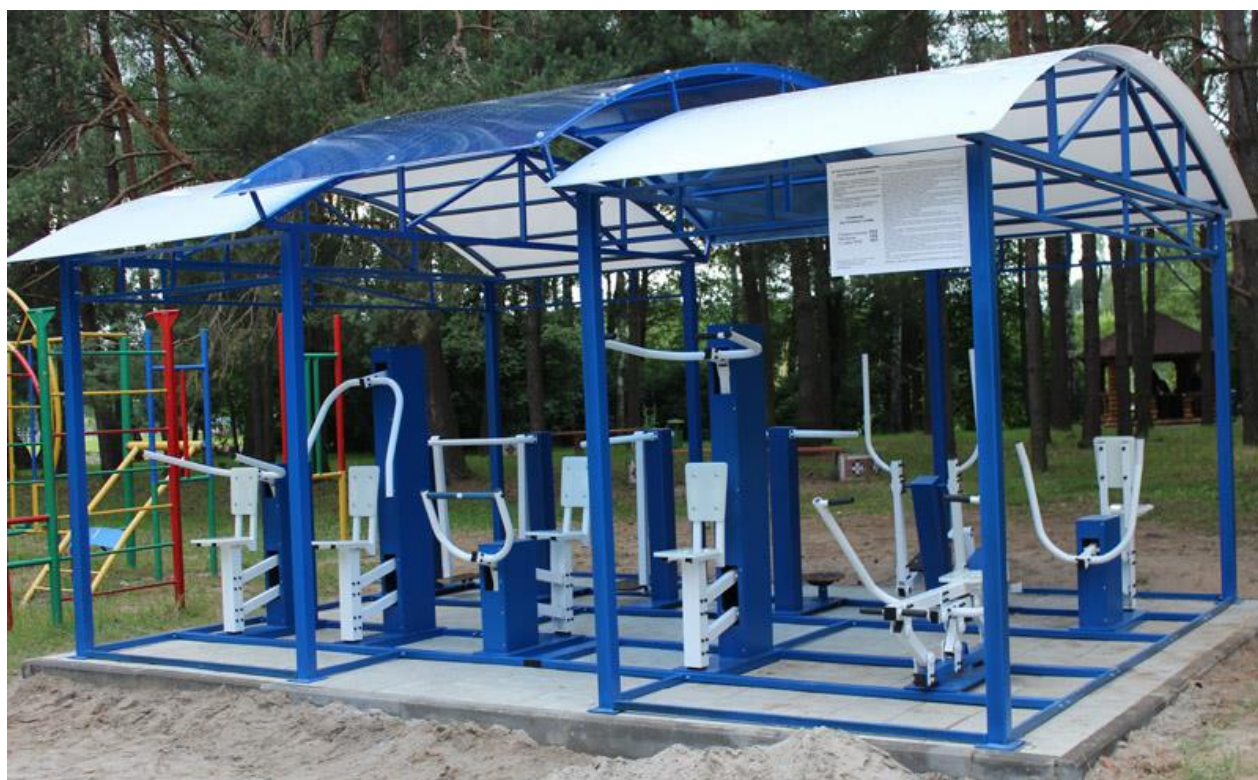
Обустройство площадки для уличных тренажеров
